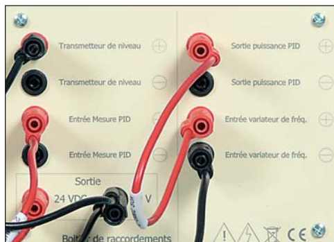
Bornero para las entradas y salidas de los sensores PID y el mando del variador
